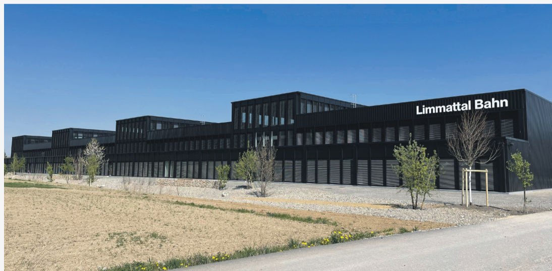
Blick auf das Depot der Limmattalbahn
